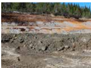
Juni 2013. Området som tidigare varit dagbrott är nu fyllt med gråberg, förorenade massor och kalk, samt har försetts med ett täcksikt.
