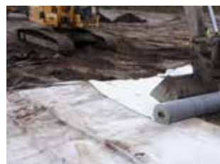
Oktober 2013. Efterbehandling av vattenbassänger som användes under reningsprocessen.
