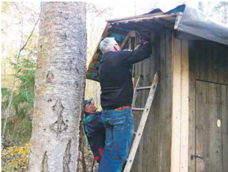
Uutta kattoa asentamassa Matti Rossi (vas.) ja Markku Lankinen
