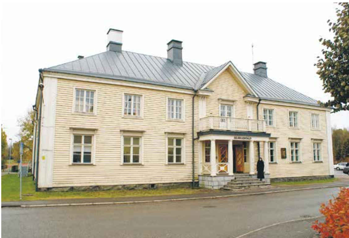
Vuonna 1926 valmistunut Mäntsälän Suojeluskuntatalo toimii nykyään Seurojentalona.
