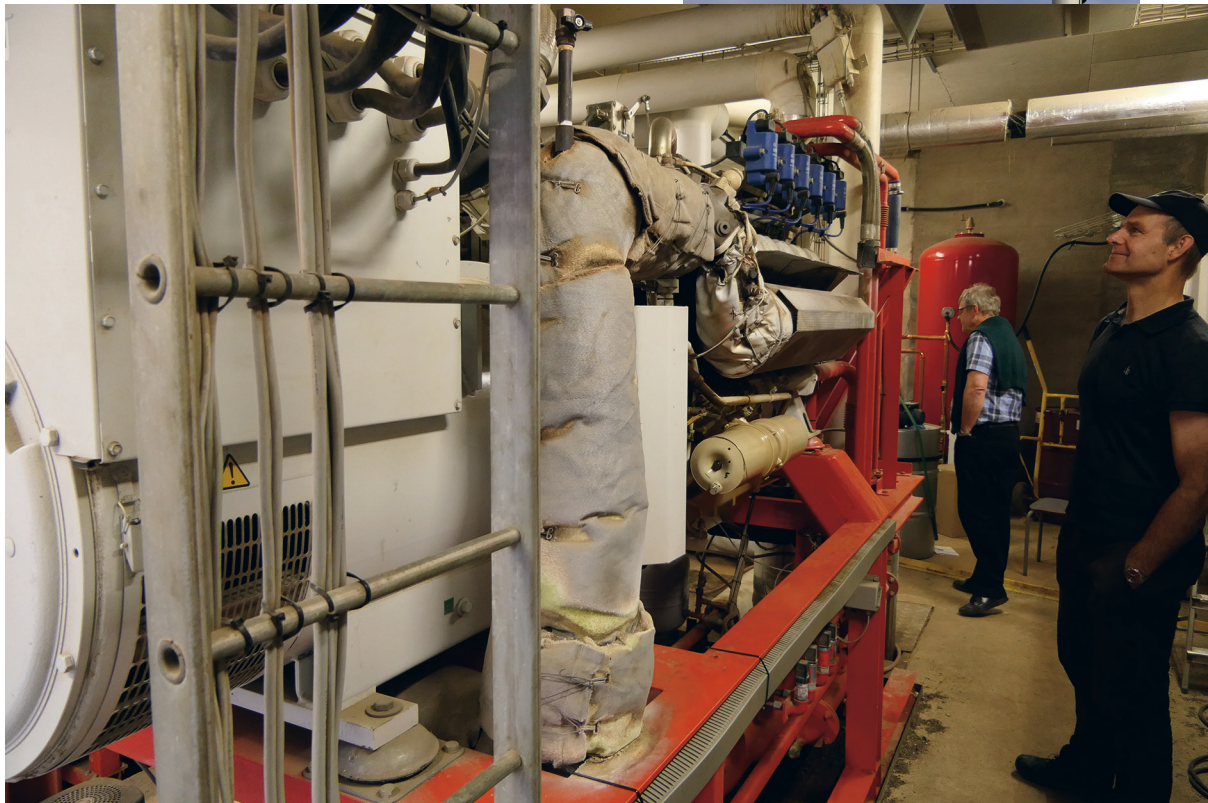
I gasmotorn omvandlas biogasen till el, värme och kyla som används på gården. Foto: Gustaf Egnell.
