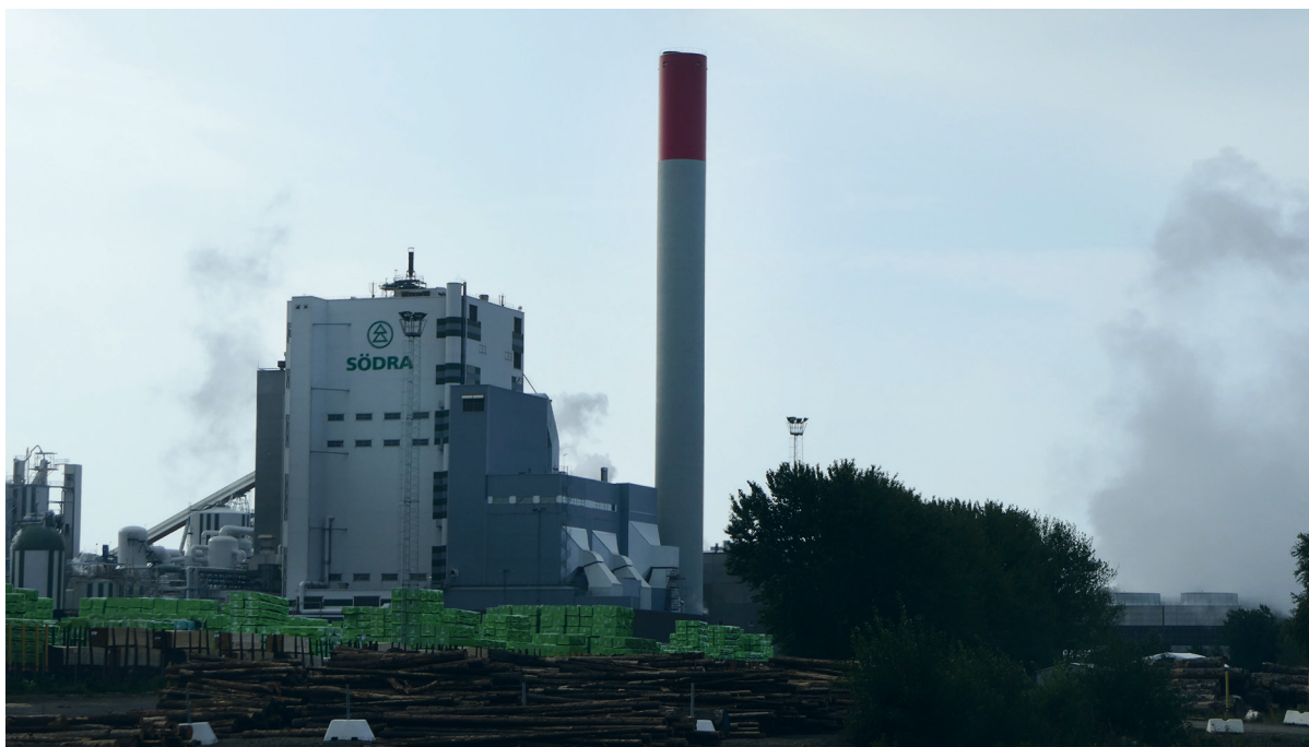
Genom att lägga massabruk och sågverk i direkt anslutning till varandra och samtidigt vara uppkopplad på Varbergs fjärrvärmenät har man kunnat energieffektivisera vid industrikombinatet Värö. Foto: Gustaf Egnell.
