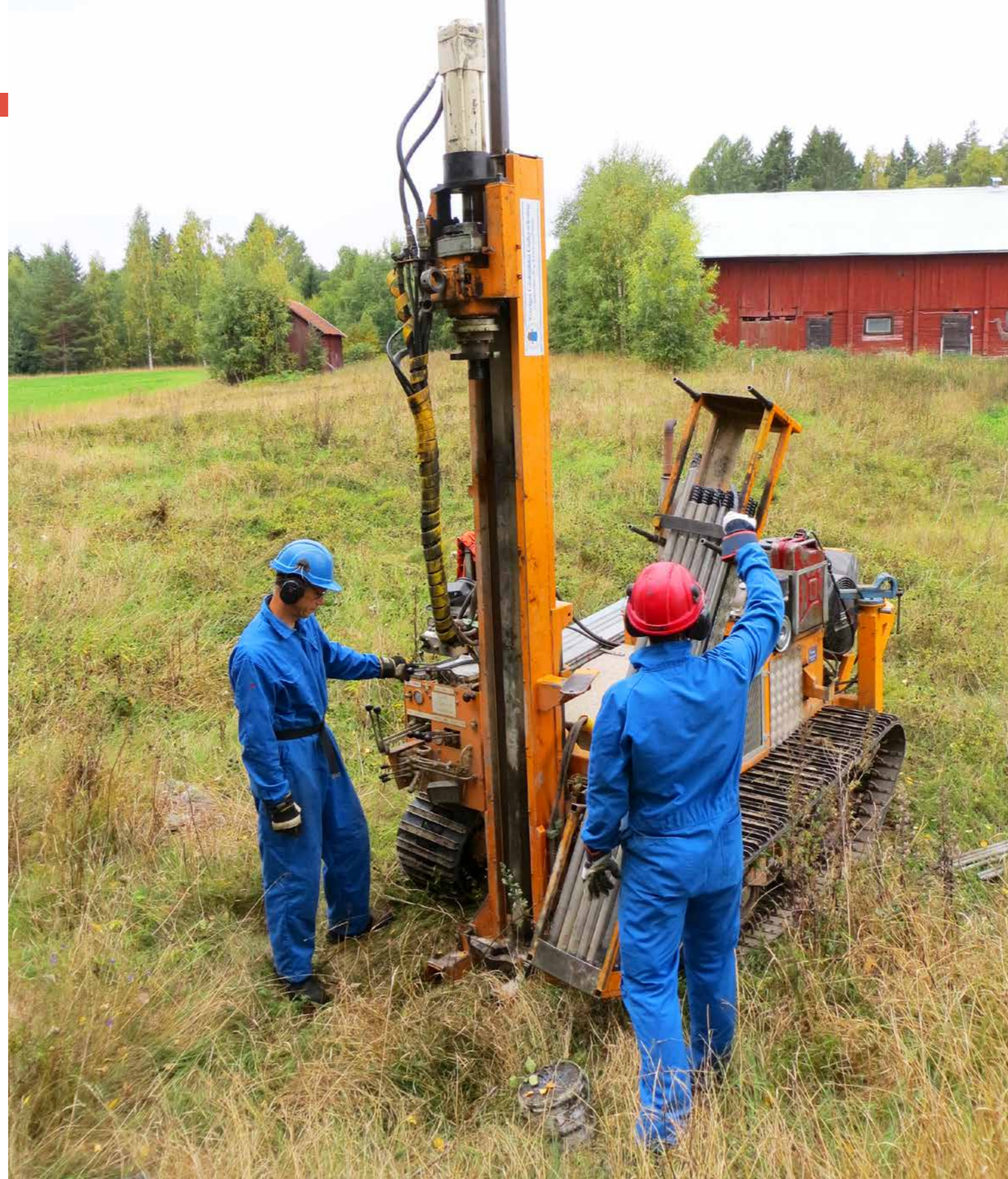
När intrång görs får markägaren ersättning, storleken beror på typen av intrång. Här borrar SGU, Sveriges geologiska undersökning, för att sätta grundvattenrör.
